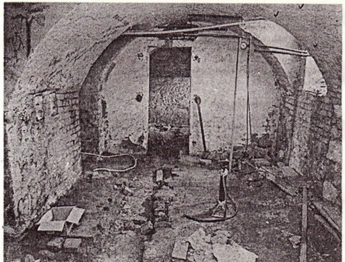
Im Keller sind bereits Versorgungsleitungen saniert und neu gelegt, darüber hinaus wurde die Grundwasserfeuchte des Fundamentes bekämpft.
